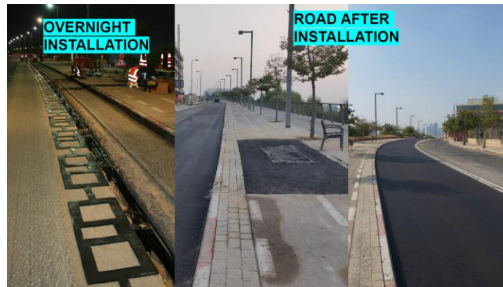
Figur 5.9 Installation av induktiv laddinfrastruktur i Tel Aviv, Israel (bild från Tongur, 2020).
